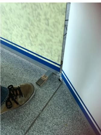
Die anschließenden Platten können mit einem untergesetzten Niveaueingleich (z.B. Zollstock) an die bereits montierten Scharniere eingesetzt werden.
