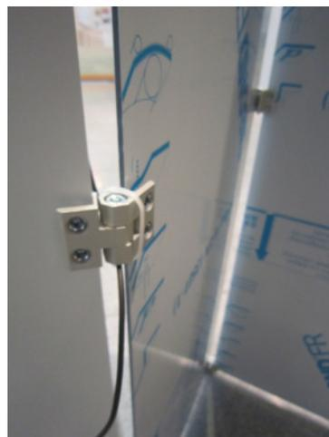
Das Kopfhörerkabel wird zwischen den Platten durchgeführt. Die Aufhängung Kopfhörer wird mit Mutter und Unterlegscheibe angeschraubt.
